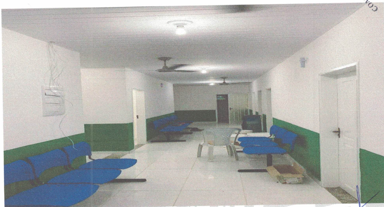
Posto de Nova Mocajuba – Serviços executados (área interna do posto).
